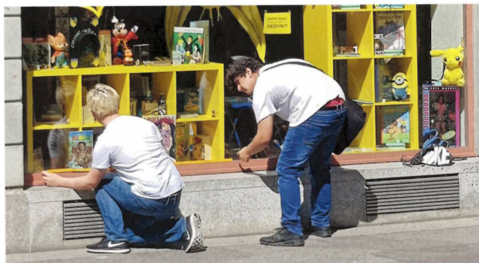
Entfernen des Schaufensterrahmens und Reinigen des Untergrunds, bevor...
